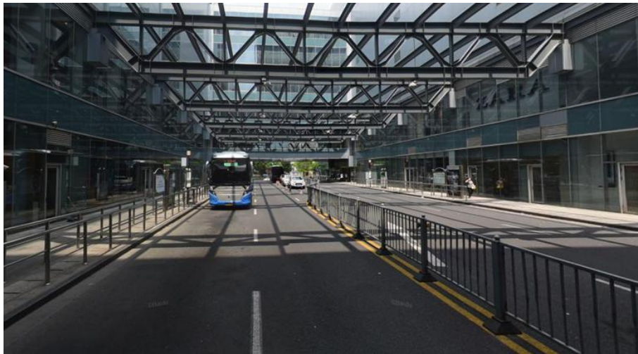
图 8 上海虹口足球场（花园路）公交枢纽站实景图（通道式布局、直列车位）
