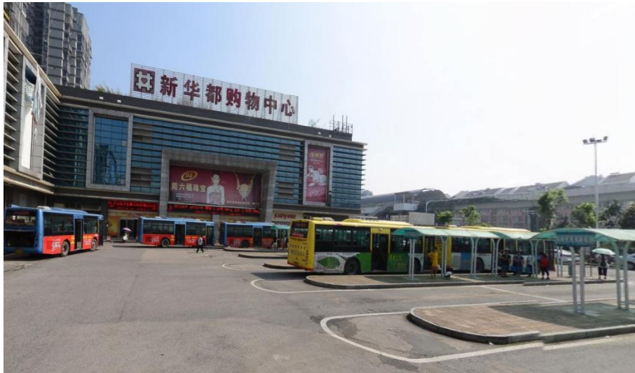
图 6 厦门嘉庚公交场站实景图（环绕式布局、直列车位）
